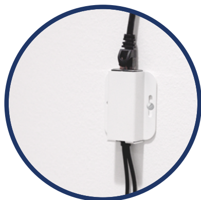
Vue agrandie de l'installation du module AC J sur un mur
