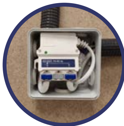
Instalação em caixa de 80 x 80mm sem os conectores F.
